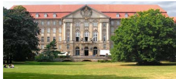
Abb. 20: Kammergerichtsgebäude in Berlin 3
