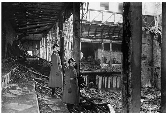
Abb. 8: zerstörter Plenarsaal des Reichstagsgebäudes 2
